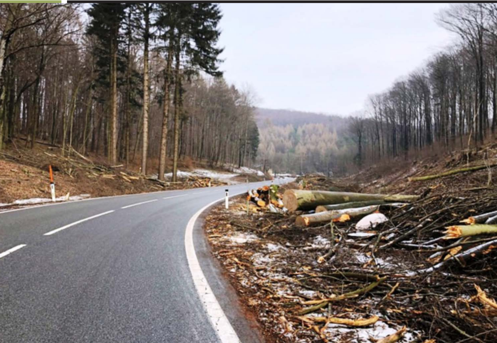
Die Bäume entlang dieser Straße wurden vorsichtshalber beidseitig in der Breite je einer Baumlänge entfernt.
