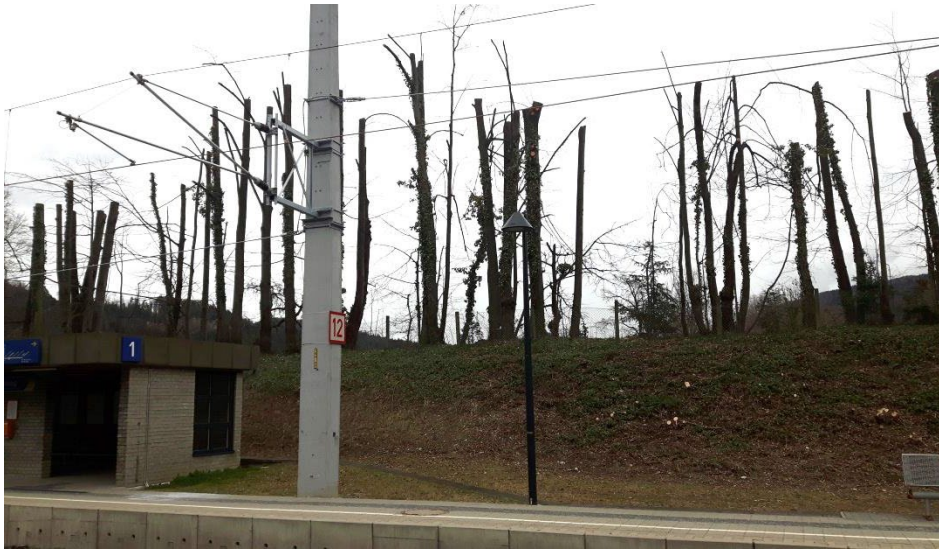
Abbildung 5: Auswirkungen der Verkehrssicherungs- pflicht an einem kleinen Bahnhof an der Südbahn. © Bernhard Schwarzl
